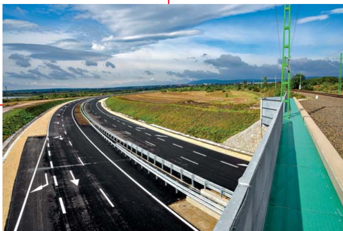
Výstavba silnice M85, 4. etapa, Sopron východ – Fertőrákos, Maďarsko Construction of M85 highway, stage four, Sopron East – Fertőrákos, Hungary
