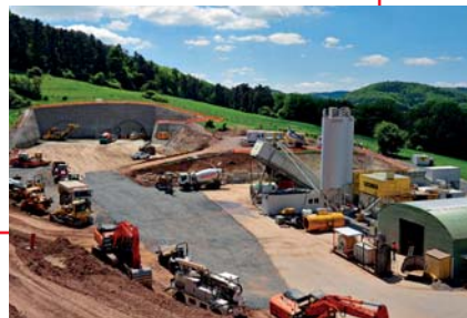
Výstavba silničního tunelu Spitzenberg, Wehretal, Německo Construction of the Spitzenberg road tunnel, Wehretal, Germany
