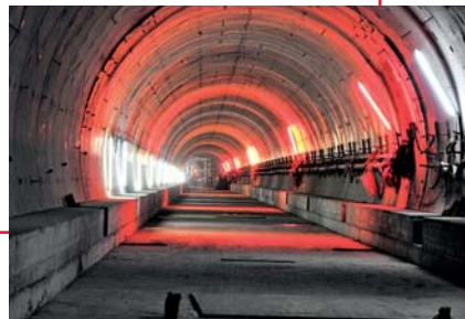
Výstavba lehkého metra v Karlsruhe, Německo Construction of light metro in Karlsruhe, Germany
