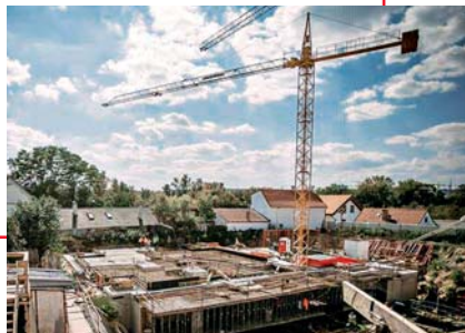
Vybavení zařízení staveniště Site facilities
