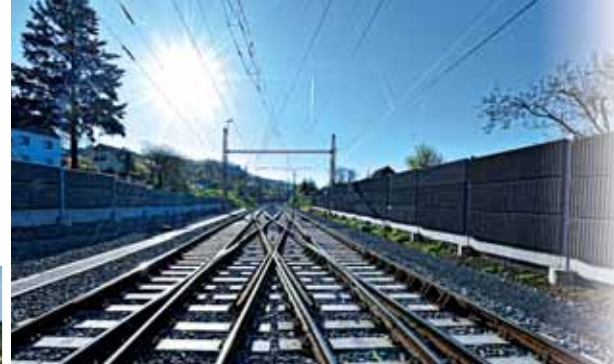
Rekonstrukce koridoru Kuřim Renovation of the railroad Kuřim, the Czech Republic
